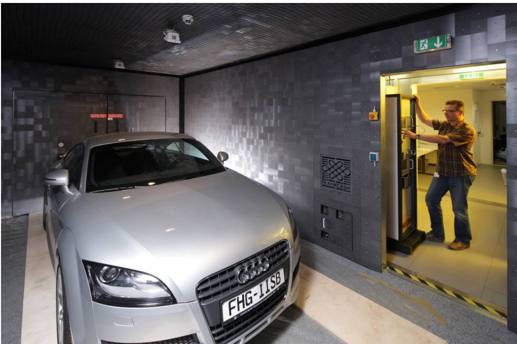
EMV-Kabine (EMV: Elektromagnetische Verträglichkeit) im neuen Testzentrum für Elektrofahrzeuge. (Foto: Fraunhofer IISB / K. Fuchs)
