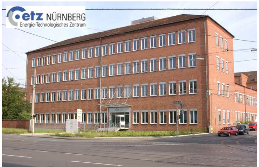
Gebäude in der Landgrabenstraße in Nürnberg, in dem die Außenstelle des IISB, das „Zentrum für Kraftfahrzeug-Leistungselektronik und Mechatronik“, im September 2004 ihre Arbeit aufgenommen hat
